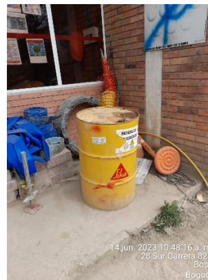
Tanque con producto Sika sin cumplir con lo establecido en el PMA frente al acopio de sustancias químicas.
