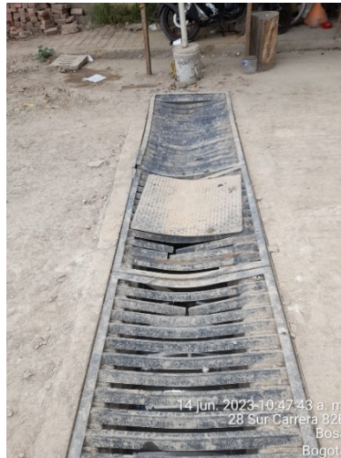
Rejilla deteriorada en puerta 1. Fecha: 14-06-2023.
