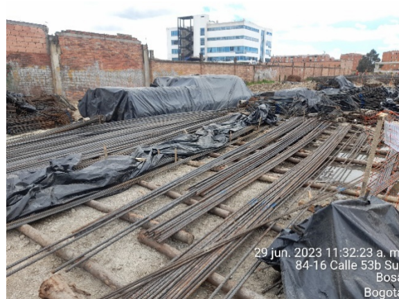
Evidencia de reutilización de madera como cama del acopio de hierro. Fecha: 29-06-2023.
