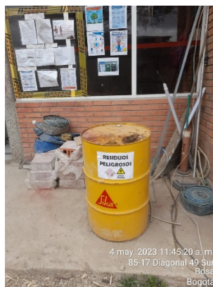
Tanque con producto Sika sin cumplir con lo establecido en el PMA frente al acopio de sustancias químicas.
